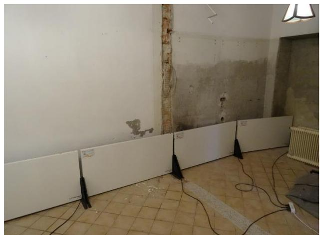
Die aufgestellten Trocknungsgeräte zur Mauerentfeuchtung
