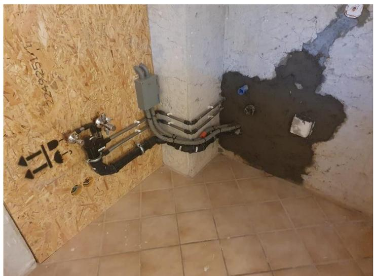
Links die Anschlüsse für den Spülbereich und rechts der neue Anschluss für den Gläserspüler
